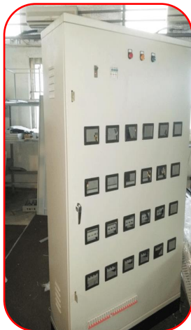
TỦ CÔNG TƠ
